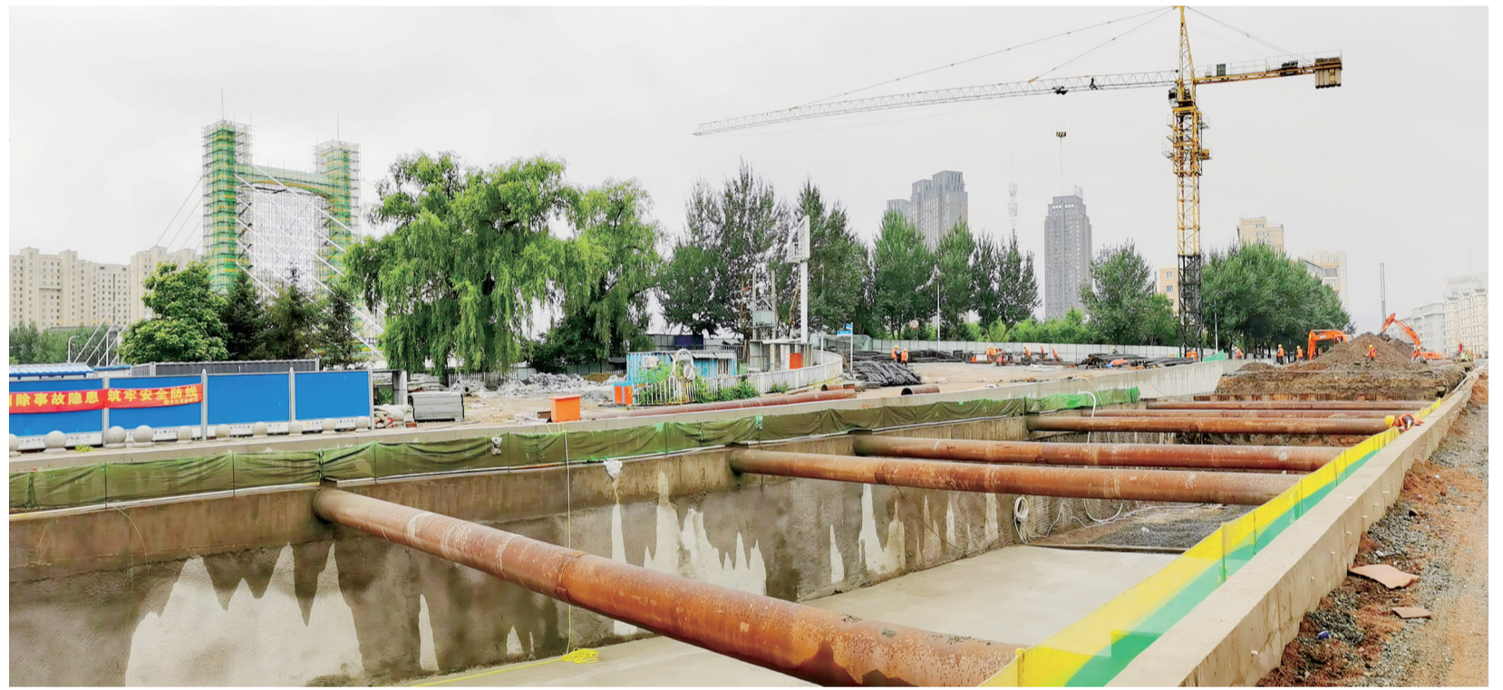
日前,记者在辽河大路下穿工程现场看到,该工程中的灌浆和支护桩作业已全部完成,管线切改工程进入尾声,主体工程建设有序进行中,预计10月中旬即可通车。 本报记者 刘鹰 摄
