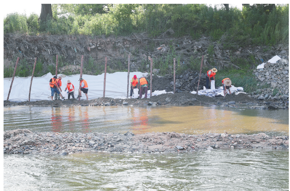
进入汛期以来,我市各相关部门积极做好隐患排查和水毁险段修复工作,以确保全市安全度汛,保障人民群众生命财产安全。图为7月9日,东辽县组织施工人员对东辽河大铁堡村险段进行除险加固。
