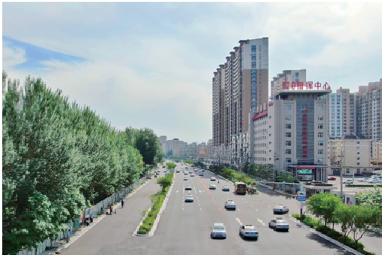
我市市政道路改造工程之一的东吉大路(龙山东街至兴华街)改造工程,历时两个多月的紧张施工,于6月26日建成通车,比原计划提前40余天。该路段的顺利通车极大缓解了城市交通压力。本报记者 夏景明 摄
