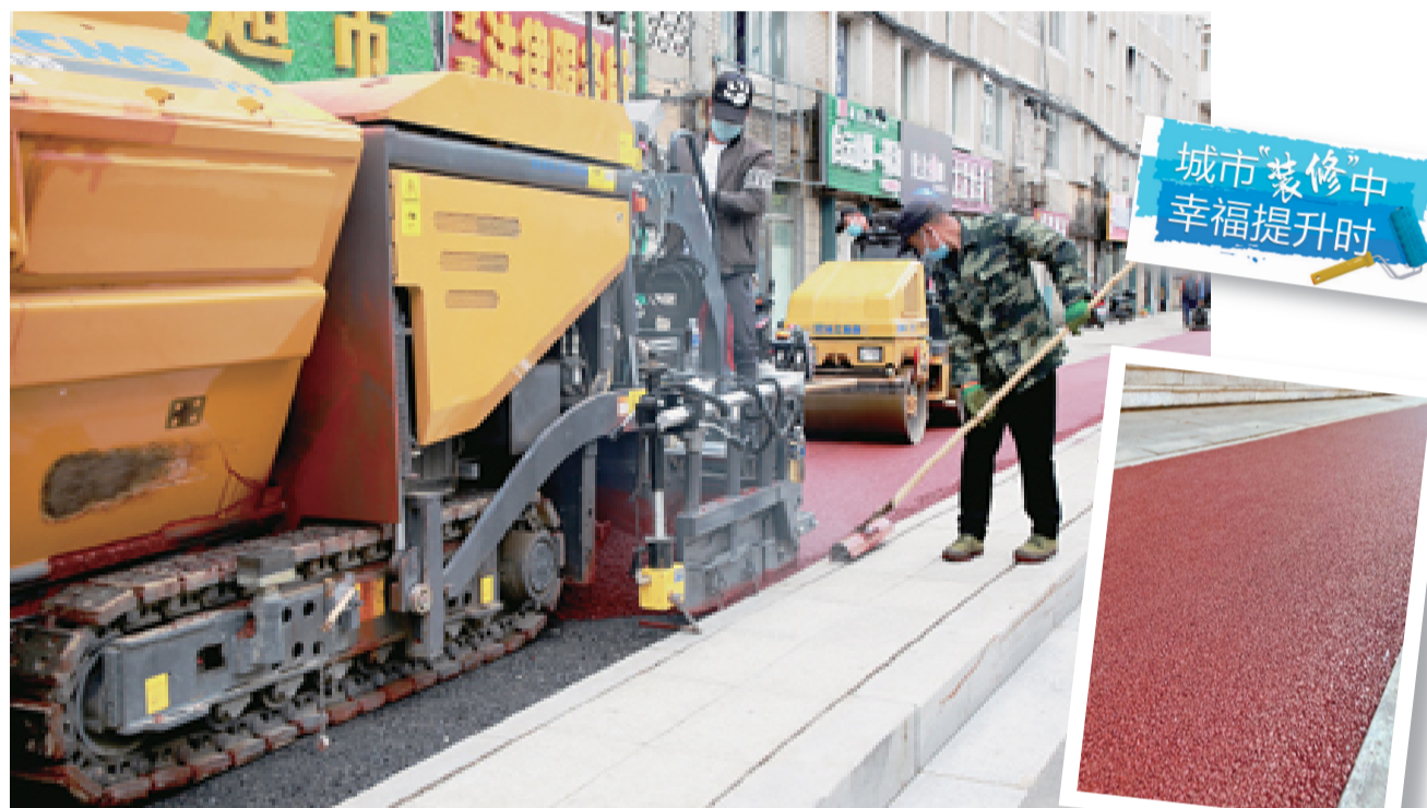
今年,我市继续实施城区街路改扩建工程,计划对全市20余条街路进行改造扩建。改造后将进一步缓解城市交通压力,提升城市整体形象。图为西宁大路(永安桥至火车站—粮库路段,改造全长1210米)非机动车道铺设彩色沥青现场。 本报记者 魏利军 张建树 摄
