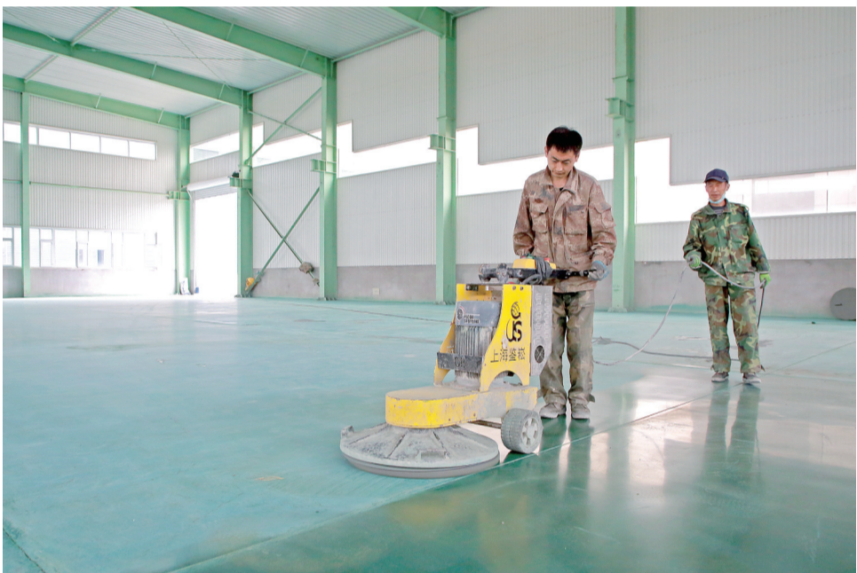
包材车间的工人正在进行固化地坪操作。
