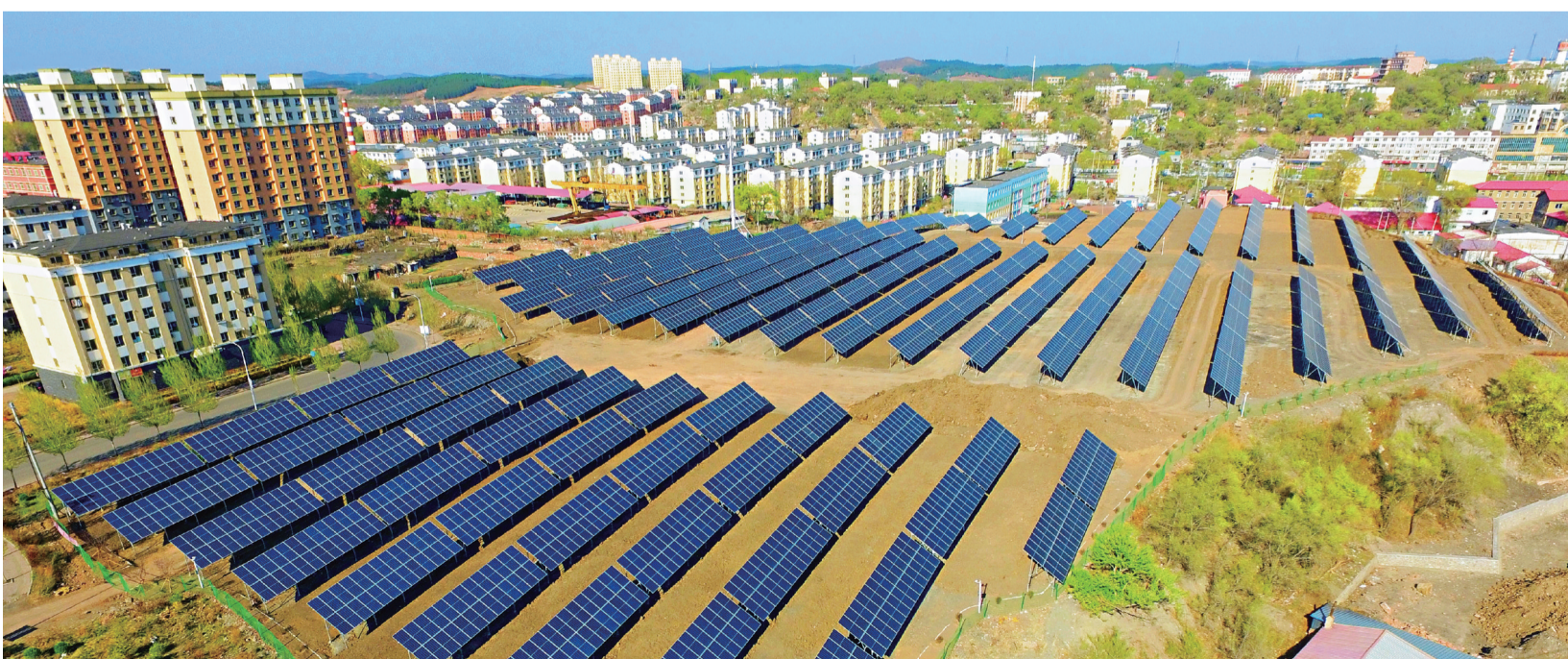
目前,西安区复工复产项目正有序推进。东星山语城三期项目主体完工。辽矿配售电有限公司光伏发电项目现场一片忙碌,6兆瓦发电站工程正在进行。图为鸟瞰辽矿集团配售电有限公司10兆瓦光伏发电项目。 本报记者 刘鹰 摄
