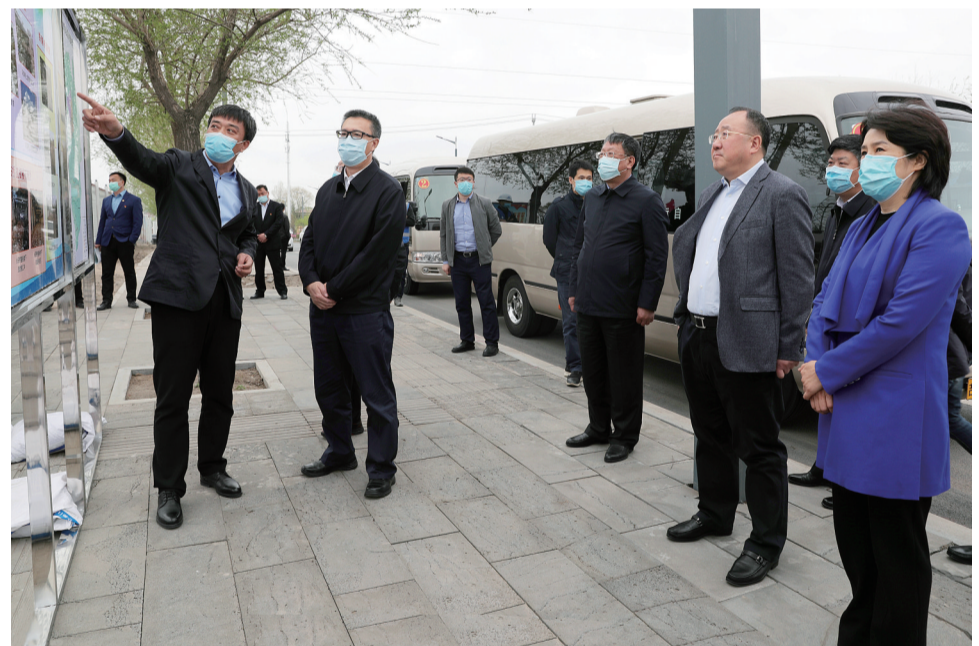
5月8日至9日,副省长韩福春(左二)深入我市12个项目建设现场,督导检查“三早”项目建设进展情况。图为韩福春在我市黑臭水体综合整治工程项目现场调研。本报记者 夏景明 摄
