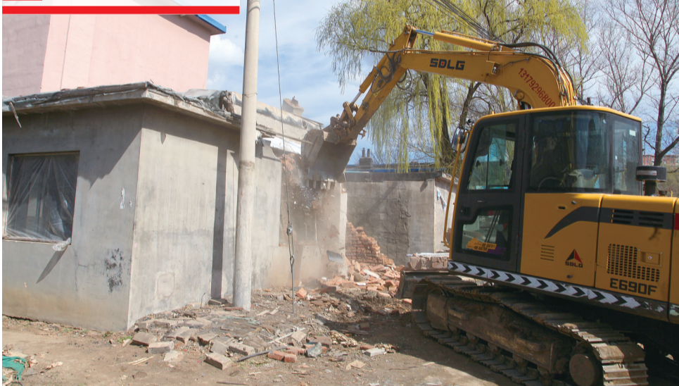
4月26日,向阳二院小区内的违建被依法拆除。
