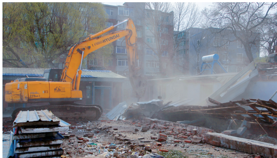
4月24日,矿医院南侧的花鸟鱼市最后3处建筑物依法评估后被拆除。本报记者 张建树 摄
