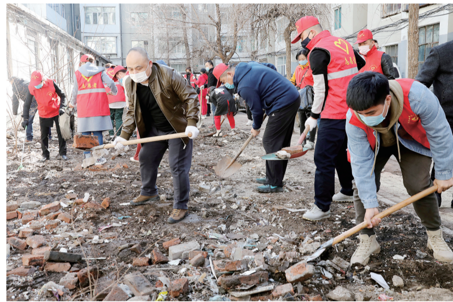
为着力解决辖区环境问题,3月29日,龙山区南康社区联合市烟草专卖局、市信访局,在建行小区93号楼后侧开展“走遍辽源”环境整治活动,对周边违章建筑进行依法集中拆除,以实际行动营造良好的宜居环境。本报记者 刘鹰 摄
