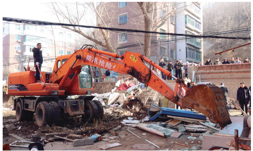
长春社区内的违法建筑被依法拆除。
