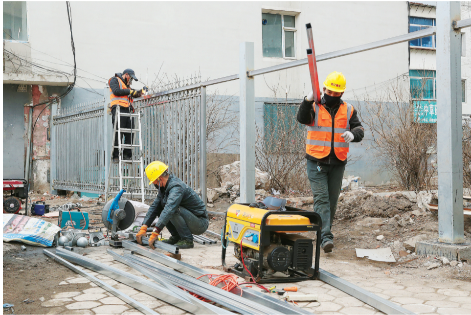
3月25日,施工人员在北寿小区进行封闭围挡安装。
