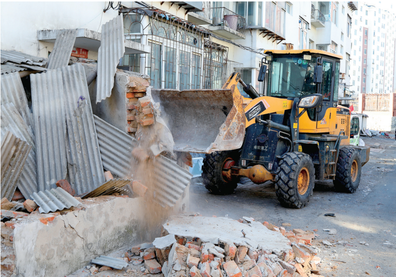
东艺社区一处违建车库、仓房被依法拆除。
