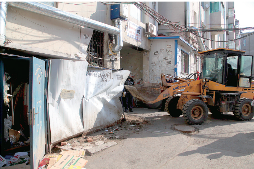
东吉社区一处居民楼下私搭乱建的彩钢房被依法强制拆除。
