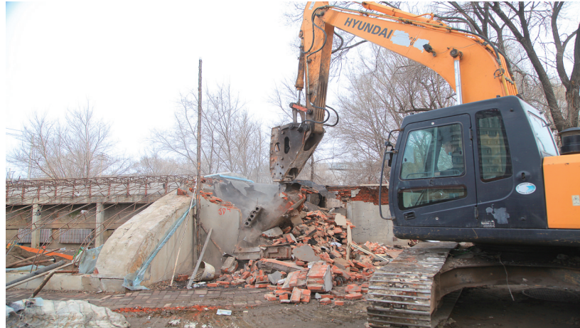
仙人河市园林处西侧的建筑物被依法集中拆除。
