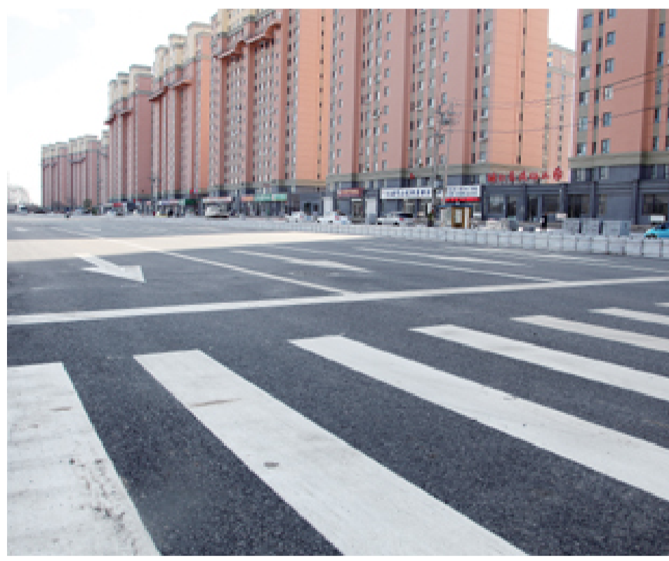
改造后的福镇大路平坦宽阔。
