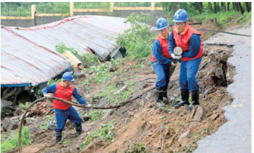
争分夺秒抢修受损电缆,为人民群众守护光明。
