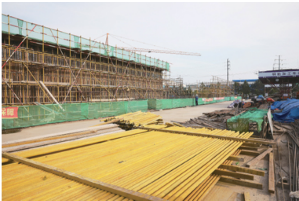
市污水处理厂提标扩能改造施工现场。
