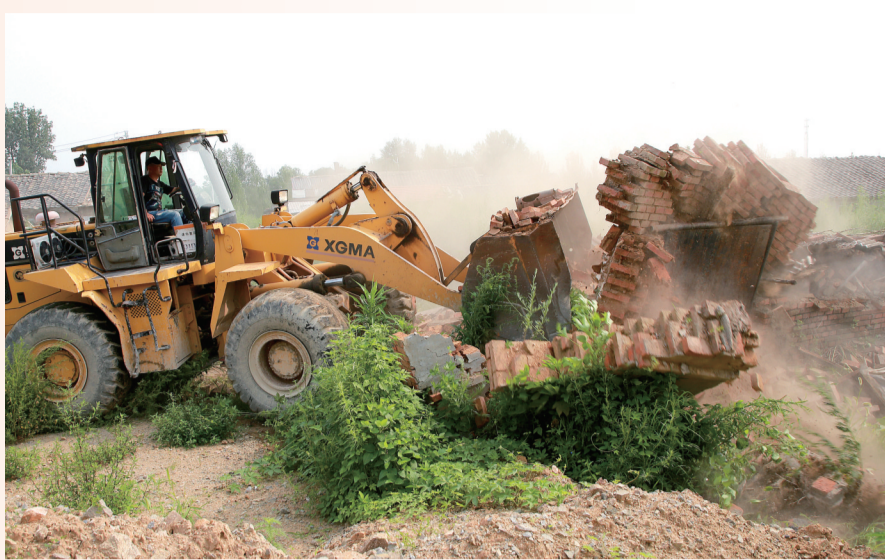
西安区泰安街违法建筑被依法拆除。
