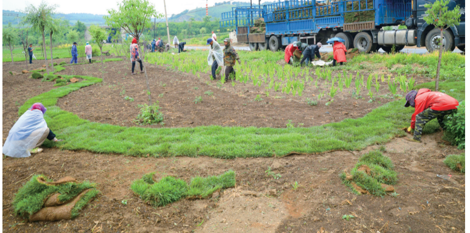
园林工人顶着小雨进行绿化景观的草坪铺装。
