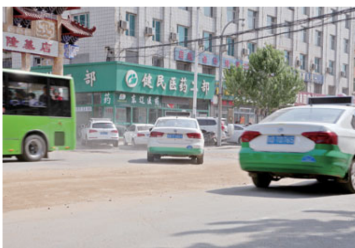
西宁大路因挖排污沟,造成路面坑洼,影响交通
