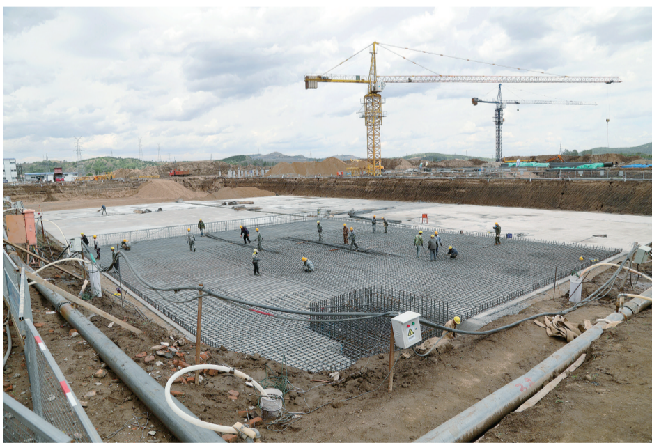
我市新建污水处理项目工地一片热火朝天的建设景象。
