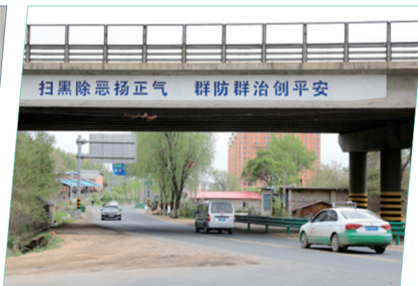
为激励全社会在扫黑除恶专项斗争发挥生力军作用,交警部门分别在城市出入口重点路段、桥梁等醒目地点,悬挂、粉刷、粘贴扫黑除恶专项斗争标语,进一步提高群众对扫黑除恶专项斗争的知晓率以及积极性和主动性。
