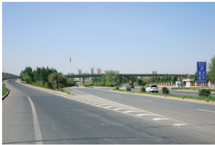
整治后的辽河大路东出口。
