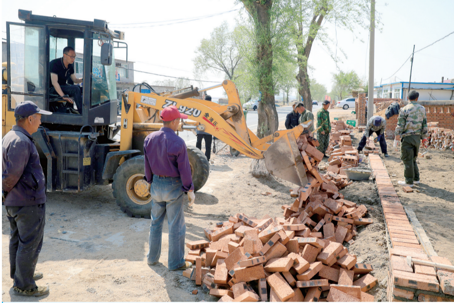
得到村民认可的庭院仿古砖墙建设已陆续开工建设。
