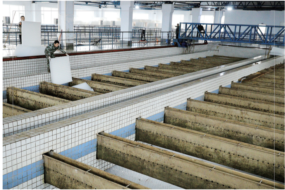
近日,为优化居民用水环境、确保优质供水,市水务集团不断加大各水场沉淀池斜管、一水水泵、阀门更换和出厂水流量计改造等工作,确保百姓吃上安全水、放心水。图为辽河水厂在进行斜板沉淀池用斜管更换作业。 本报记者 刘鹰 摄
