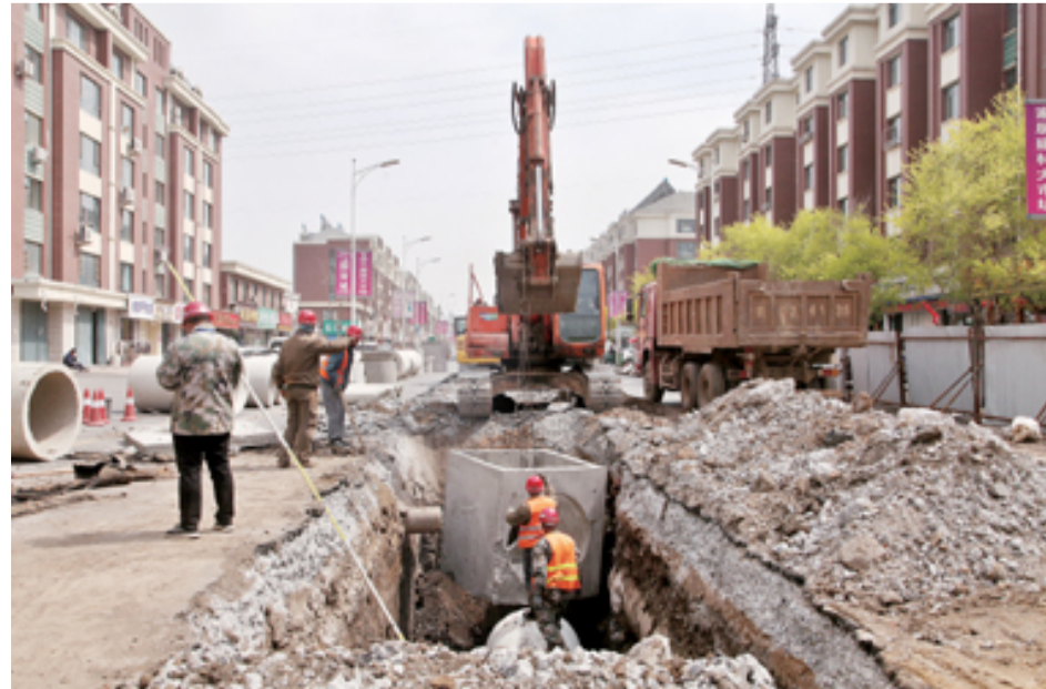
大型机械对新建雨水井进行吊装安装作业。
