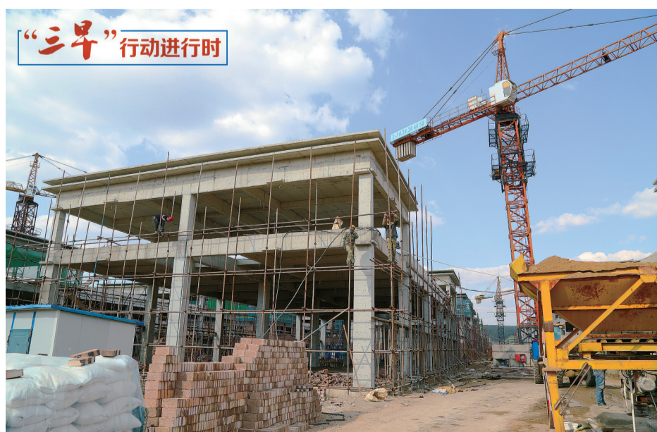
辽源·汽车商贸物流特色小镇施工现场。
