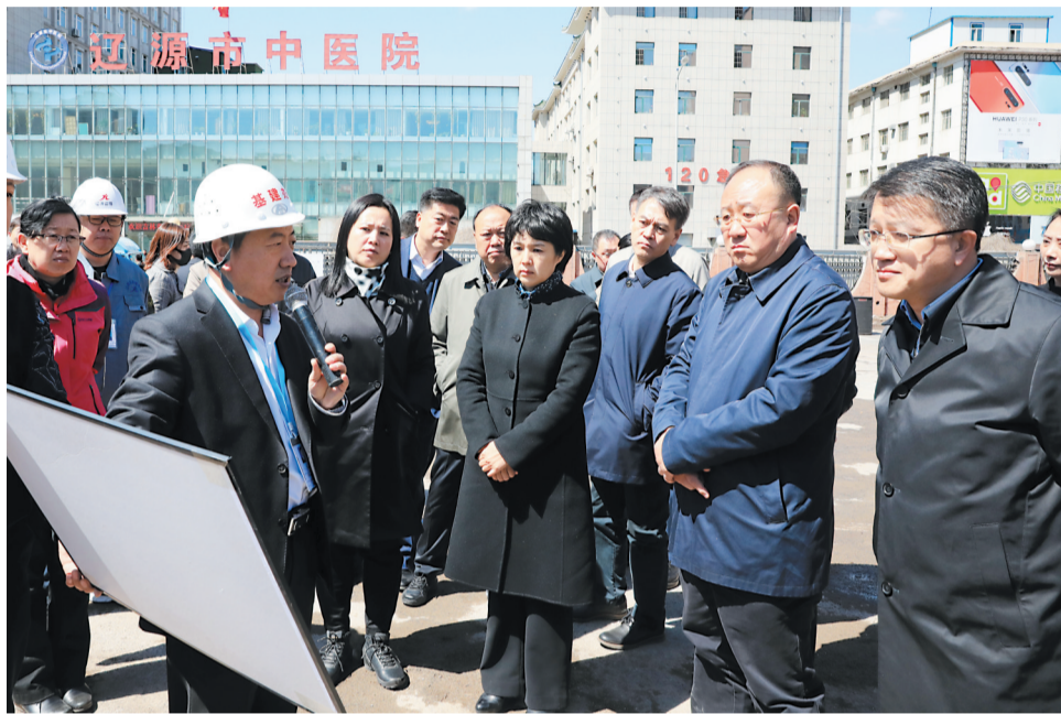
4月18日,市领导率队巡检2019年我市“三早”项目开复工情况。图为市领导在市中医院中庭大医政改扩建项目现场听取建设情况汇报。
