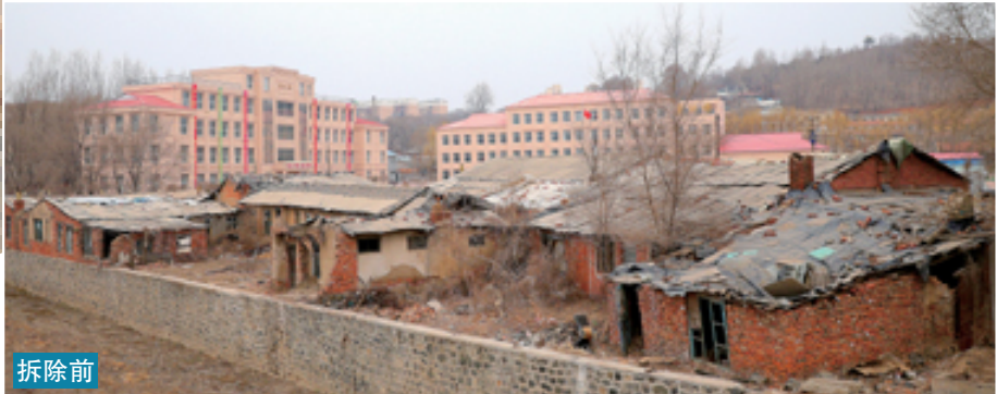
位于伊通高速方向出口处田家炳高中前的违法建筑房屋已全部拆除,之前杂乱无章的场景已不复存在。
