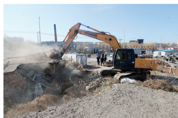
4月3日,西安区联合各部门,对位于家园供热北侧、西安区企业规划用地范围内的三处违法建筑物实施依法拆除。本报记者 夏景明 摄
